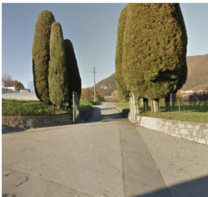
Entrata Mezzana per il frantoio
